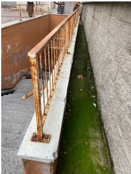
Ristagno acqua tra muro scale e muro ferrovia
