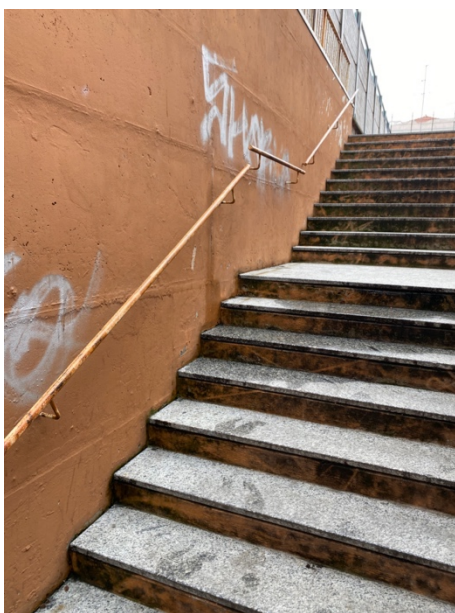
Infiltrazioni su muro scale
