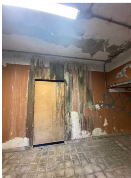
Infiltrazioni interne al sottopasso lato Nord
