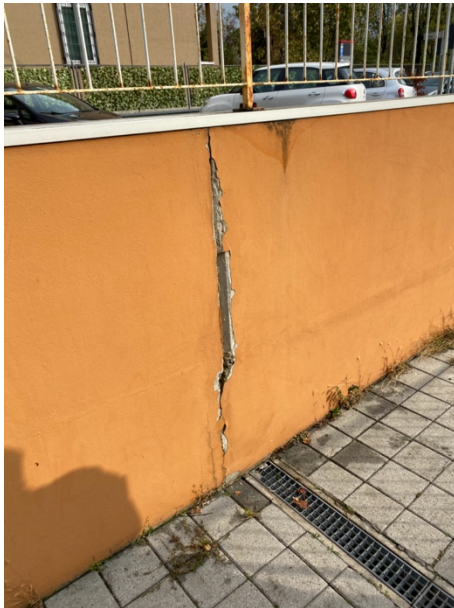
Deterioramento rampa Sud 1
